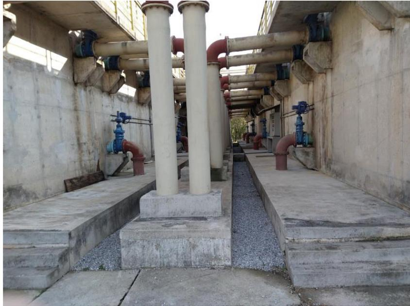
*Foto 3 Vista das paredes laterais de dois reatores UASB, com destaque para os tubos de alimentação e coleta de lodo e escuma*
