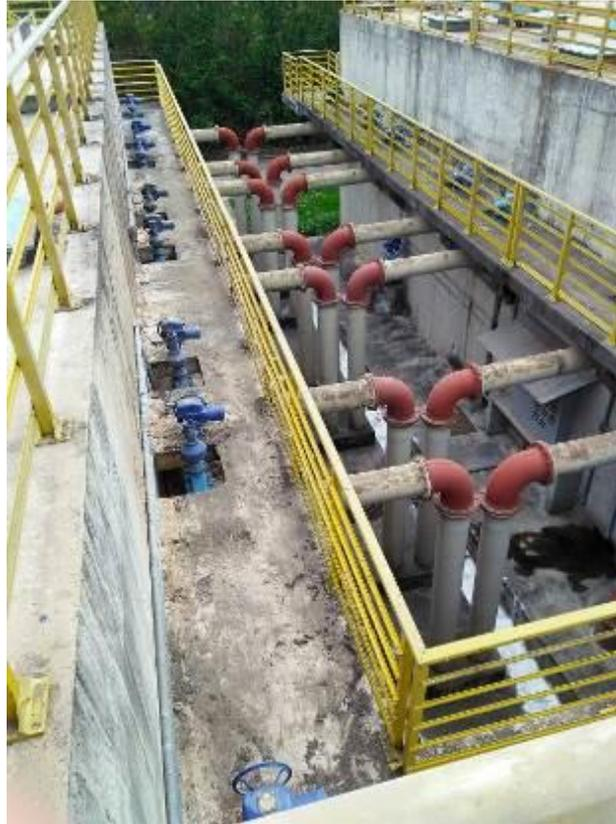
*Foto 42 ETE Central - UASB - descarte da manta de lodo*
