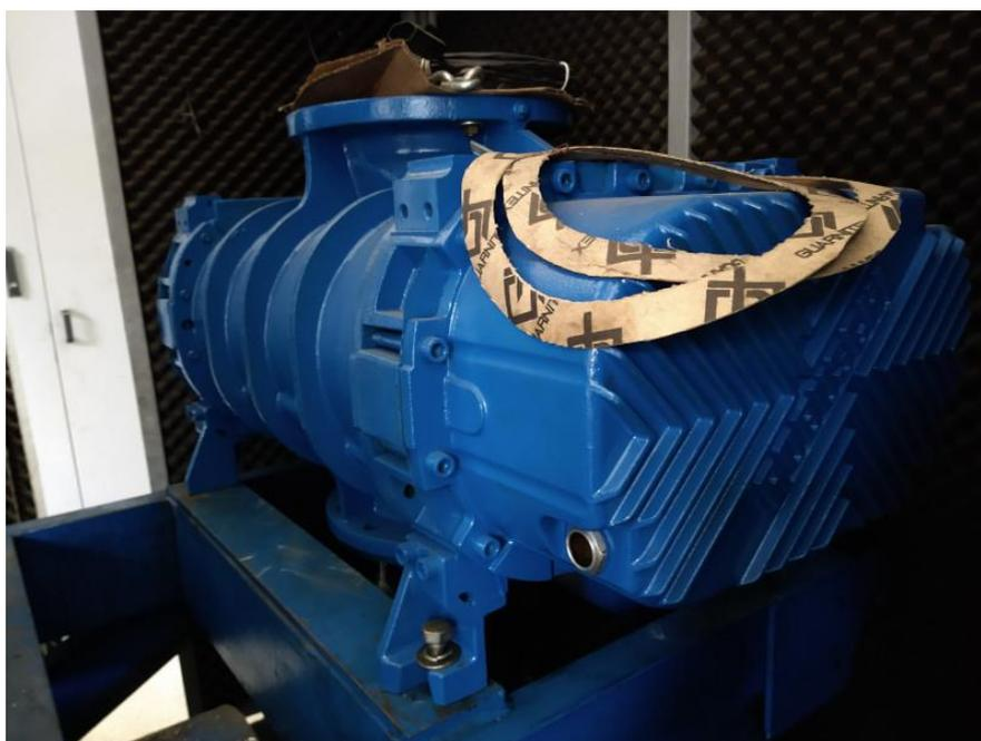
*Foto 6 Vista de um dos sopradores do sistema de aeração (em manutenção)*
