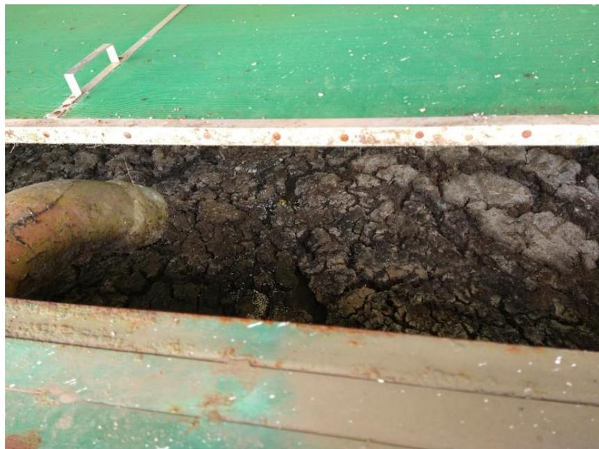
*Foto 12 Vista parcial de uma das células de leito de secagem com destaque para a tela de cobertura*
